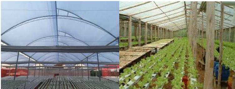
**Figura 12.** Estufa em semi-arco com saída de ar quente (esquerda) e estufa tipo capela com duas águas (direita). Fonte: Própria (2018).
