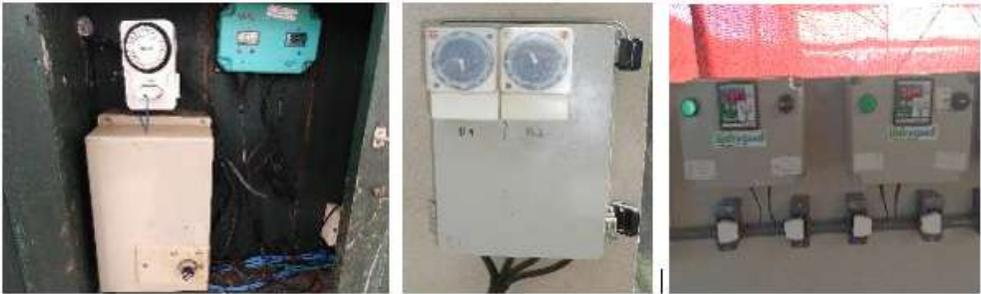
**Figura 38.** Sistema simples de automação para hidroponia: temporizador analógico e quadro de acionamento da bomba e monitor de pH e condutividade elétrica (esquerda e centro) e temporizador digital (direita). Fonte: Própria (2018).
