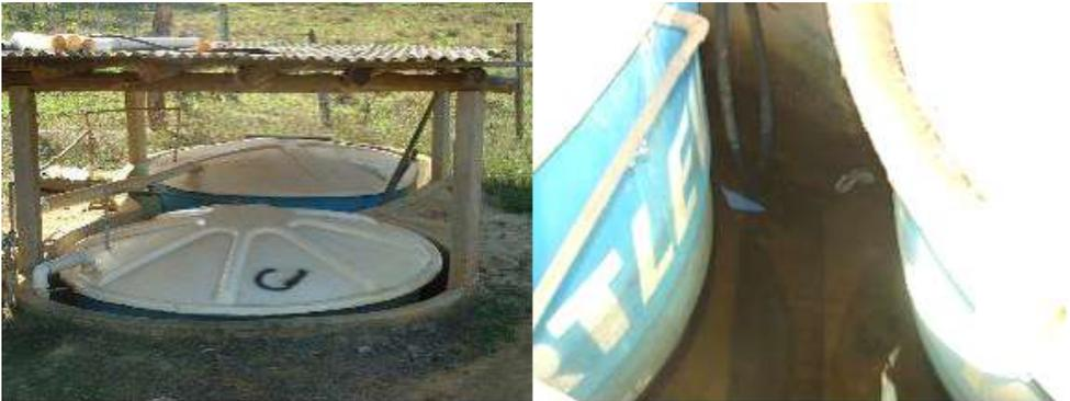
**Figura 41.** Reservatórios de solução nutritiva banhados a água para refrigeração.
