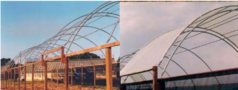
**Figura 11.** Construção de uma estufa tipo arco, com madeira e arcos em aço galvanizado (zincado). Fonte: Própria (2018).
