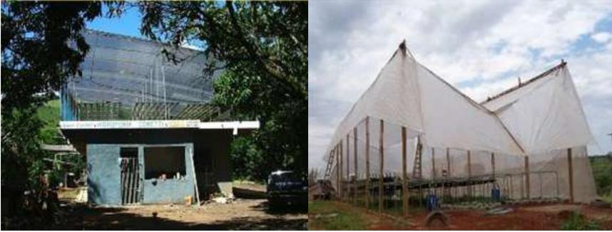
**Figura 13.** Estufa em uma água sobre uma casa (esquerda), estufa em duas águas com estrutura em bambu (direita) Fonte: Própria (2018)
