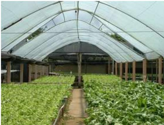
**Figura 3.** Modelo de estufa popularizado no Brasil. Ver detalhe de saída de ar quente em abertura no telhado. Fonte: Própria.
