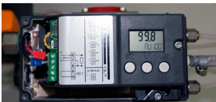
c) Aplicar o sinal elétrico de 4 mA e verificar a posição da válvula, Figura 14.7. Fazer o mesmo para 20 mA, Figura 14.8:
