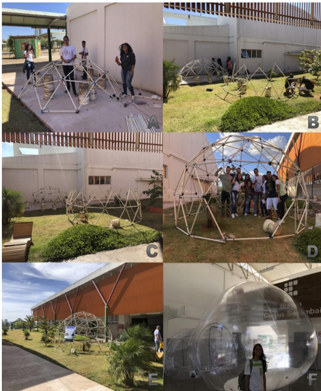
por nós. Por questões estruturais, a membrana plasmática foi montada nesse momento ao lado da estrutura em PVC, visto que não realizamos nenhum cálculo estrutural nem testamos a resistência das estruturas para sabermos se ela seria capaz de sustentar também o peso do balão inflável quando vazio (Figura 5).
