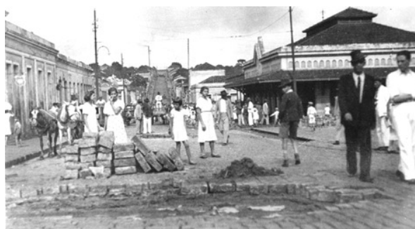
Figura 7: Pavimento de paralelepípedos da Rua Geminiano Costa destruído por inundação em 1940 (Fonte: FotoArte in MENDES E MENDIONDO, 2007).
