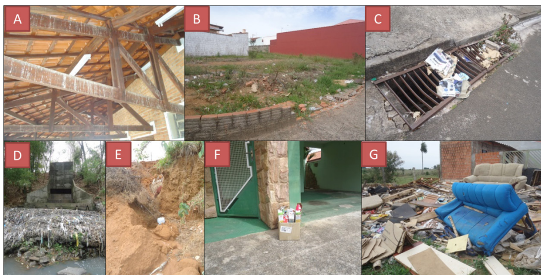
Figura 6: A- Quiosque da praça central abandonado e infestado por pombos; B- Terrenos baldios sem manutenção adequada; C- Bueiros obstruídos por resíduos; D- Ponto de escoamento da água pluvial do bairro sem manutenção adequada; E- Pontos de erosão; F- Problemas com a coleta seletiva; G- Pontos de acúmulo de entulho.
